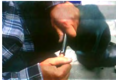
圖 4-38 PE 管與 T(L)型水管接頭接合
