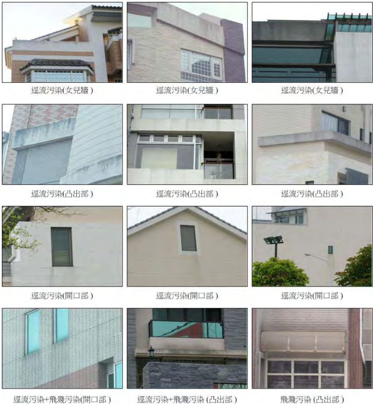
圖1 雨水與灰塵對女兒牆、凸出部、開口部污染情形
