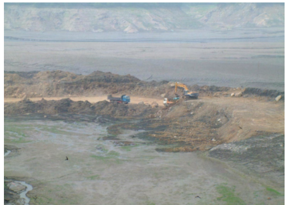
圖 1-1 石門水庫中游段阿姆坪附近機械清運
