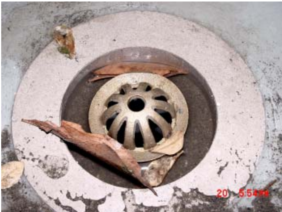
圓頂式落水孔蓋阻擋樹葉的情形
