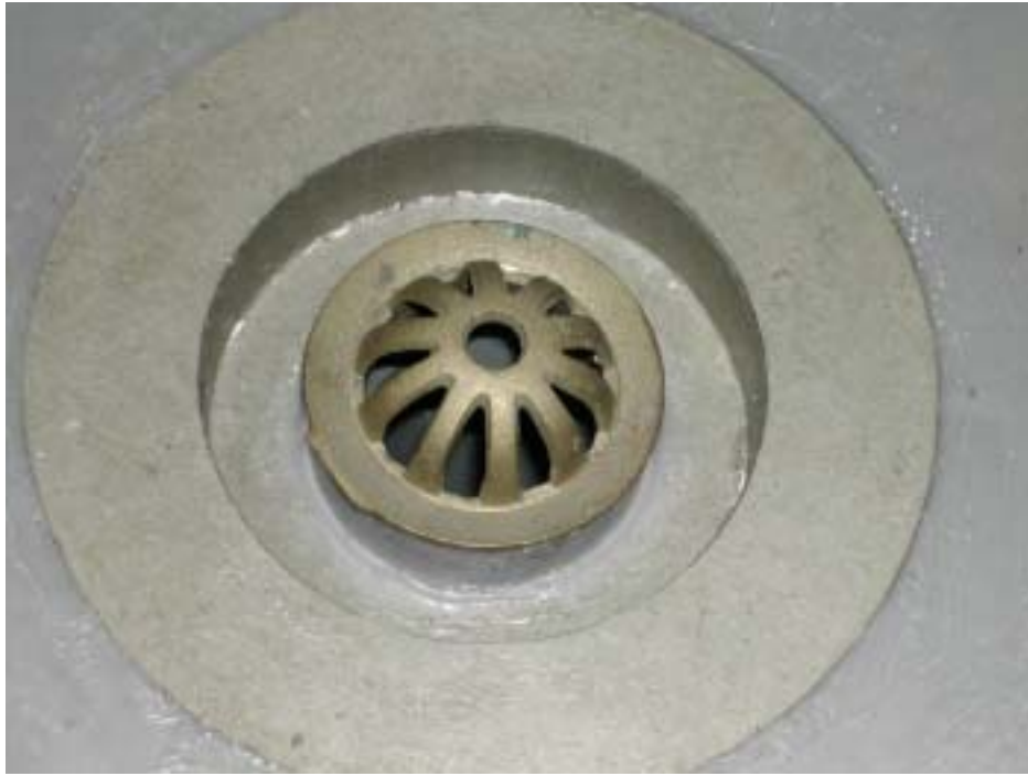
為了防止樹葉覆蓋將平頂式落水孔蓋改換成圓頂式落水孔蓋
