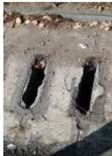
圖 34 水溝網破洞
