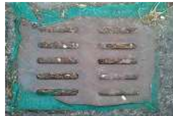
圖 35 水溝網堵塞
