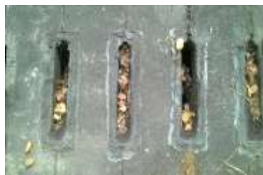
圖 5 R.C 水溝蓋紗網阻塞
