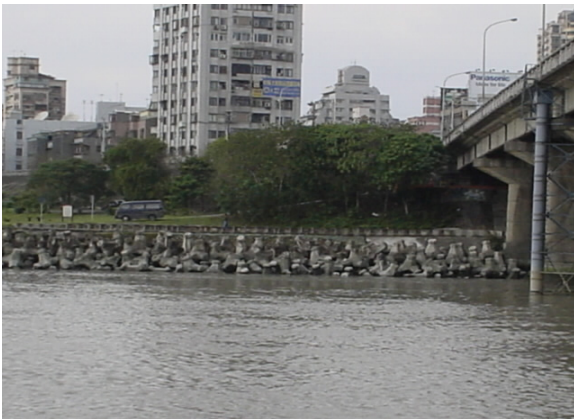
圖十五、新店溪中正橋下附近沿岸，可看見四腳林克消波塊及自然河岸。
